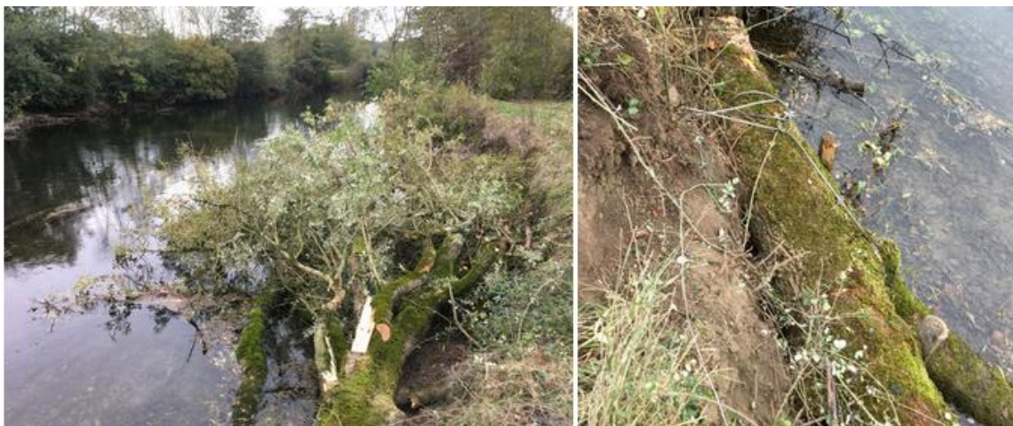
Arbre câblé en berge
