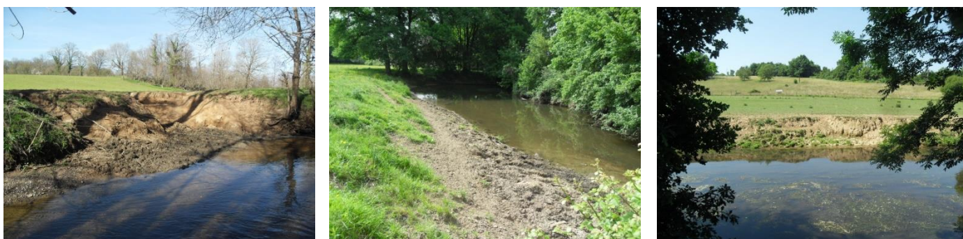
Figure 21 : Impact du bétail sur les berges et le lit de la Charente Amont
